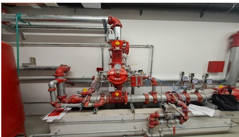
Slika 2. Stanica sustava s pjenom
