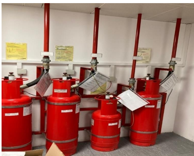
Slika 7. Spremnici sustava FM-200
