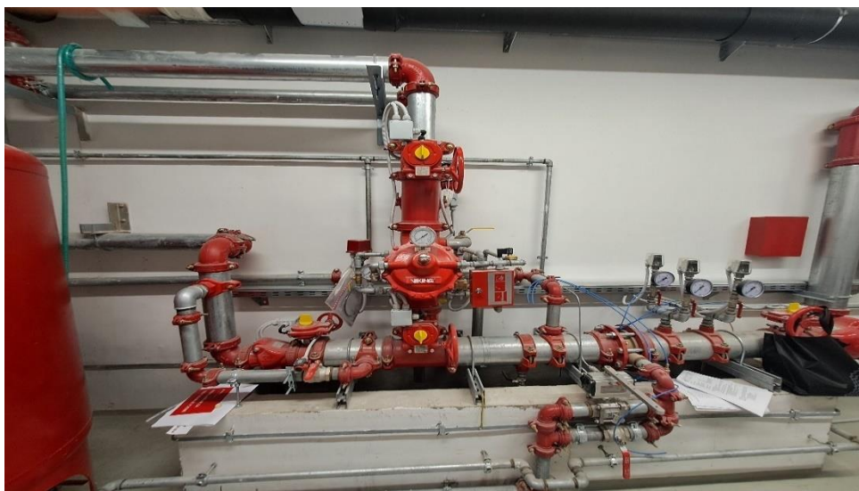
Slika 2. Stanica sustava s pjenom
