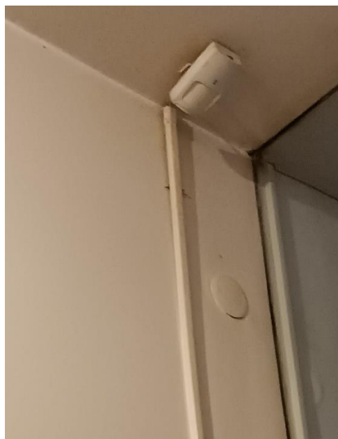
Slika 18: PIR detektor
