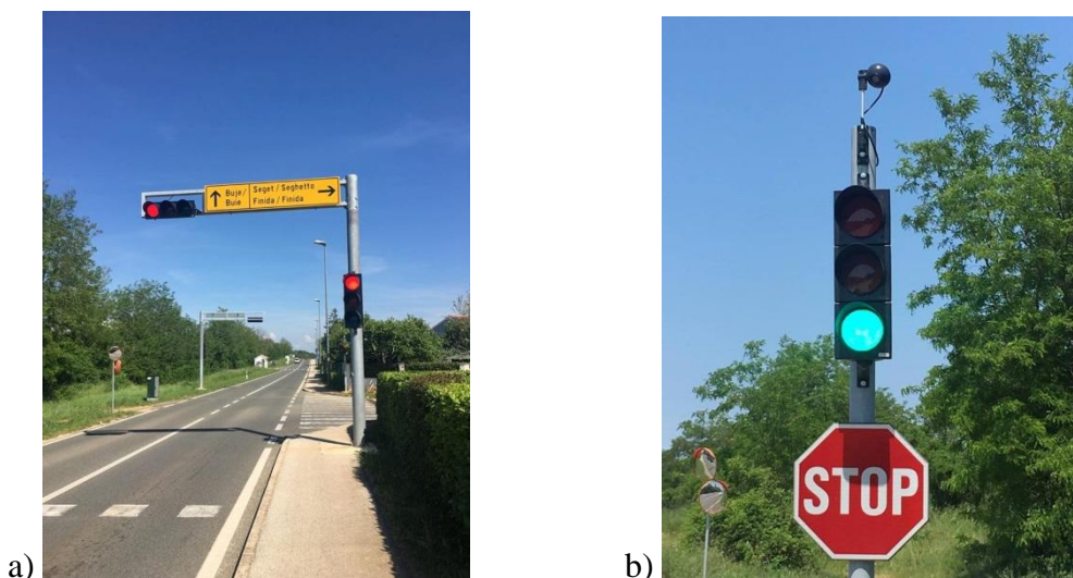
Slika 6. Semaforski uređaj na: a) glavnom i b) sporednom djelu priključka na D300
