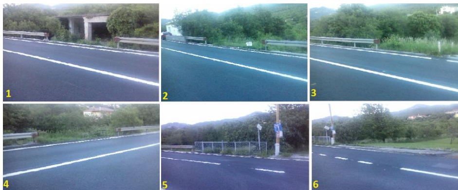
Slika 18. Prekidi u zaštitnoj ogradi
